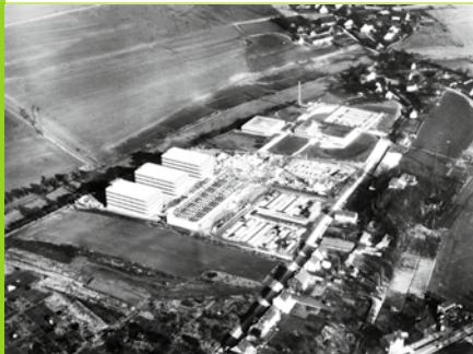
Bauphase am Campus Süd
